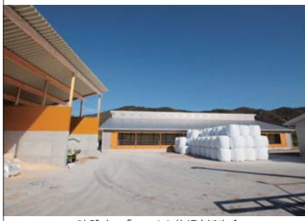
建設中の「ののむら牧場」新牛舎
